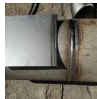
溶接焼けの除去
