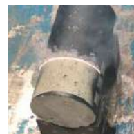
ペンキの除去 （コンクリート）
