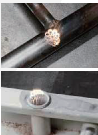
上：溶接焼けの除去の様子 下：塗装の除去の様子
